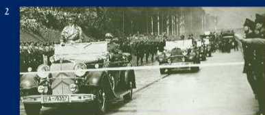
2 The unemployed are put to work on the construction of highways, government buildings and civil projects. Hitler also begins to build up a weapons industry and a large army. Unemployment falls dramatically. I disoccupati vengono impiegati per la costruzione di autostrade, di edifici governativi e lavori pubblici. Hitler promuove anche lo sviluppo dell'industria bellica e la creazione di un grande esercito. La disoccupazione diminuisce molto rapidamente.
